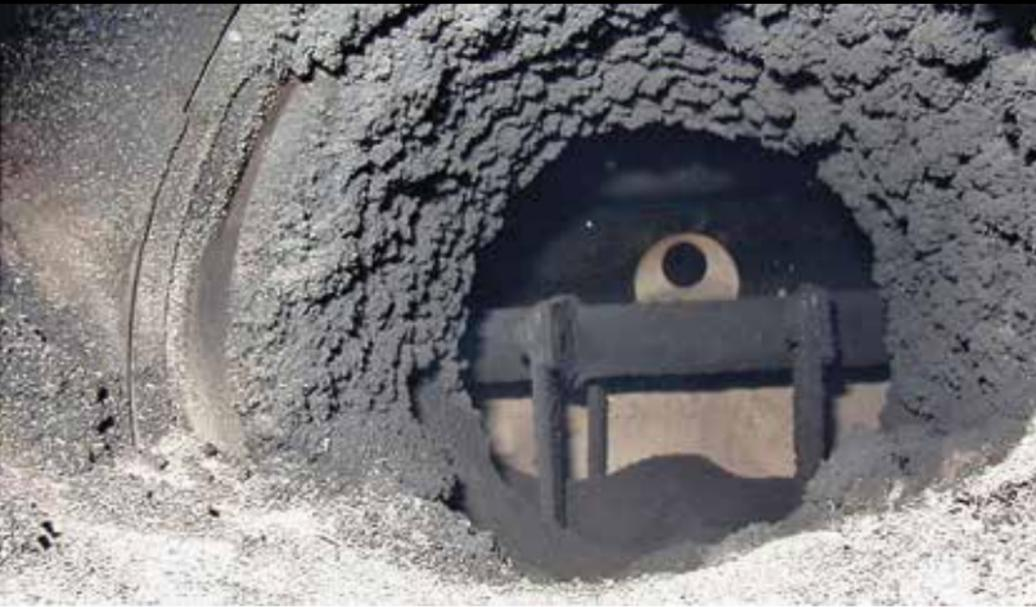
*Rußablagerungen im Rauchrohr behindern den Abtransport der Abgase.*
